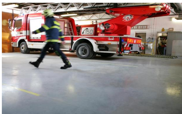
Drátkobetónová podlaha so vsypom a zhladením.
