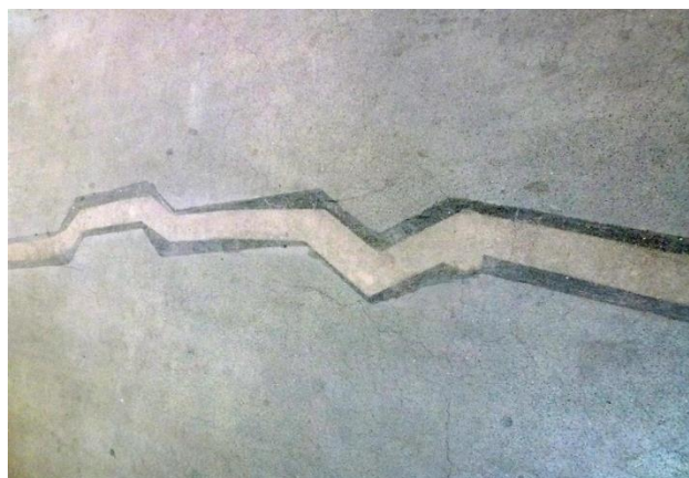
Oprava trhliny v betónovej podlahe.
