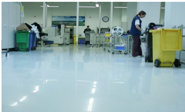
Antistatická epoxidová podlaha - fotovýroba.
