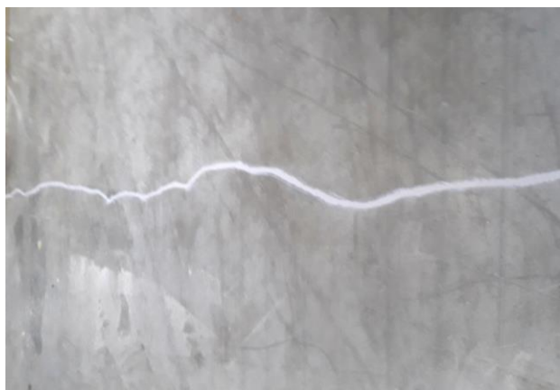
Oprava trhliny polyuretánovým tmelom
