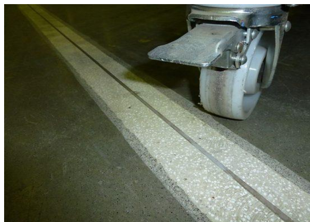
Oprava dilatačnej škáry polyuretánovým betónom.
