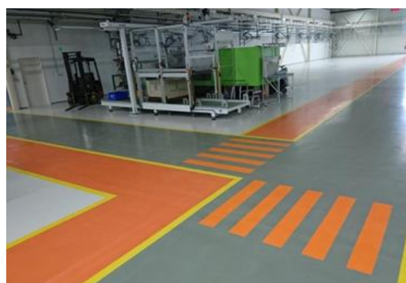
Vodorovné dopravné značenie - epoxidový náter.
