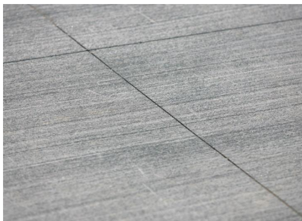
Cestný betón CBIII – detail metličkovej štruktúry.
