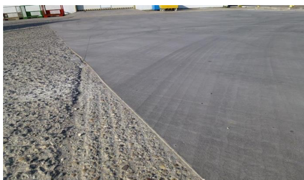
Samonivelačná cementová podlaha – parkovisko.
