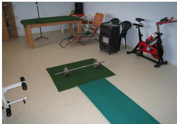
Epoxidová podlaha s čípsami a lakom.
