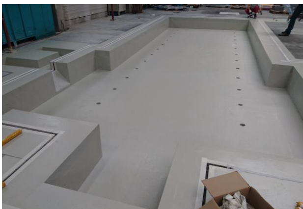
Základ pod stroj.
