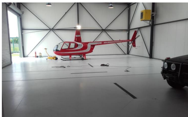
Epoxidový náter betónovej podlahy - garáž.
